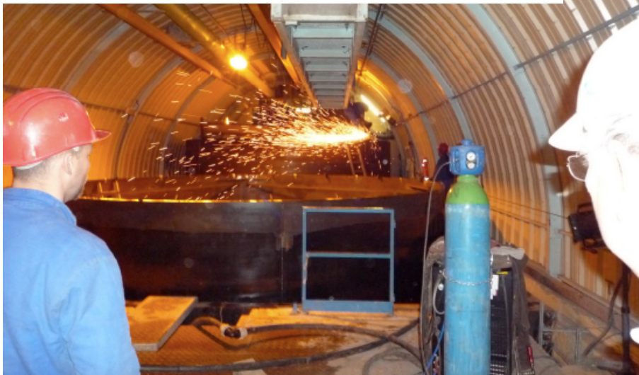
2008.11 外部鉄タンク設置
