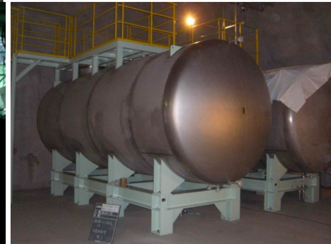
新空洞・LS貯蔵タンク
