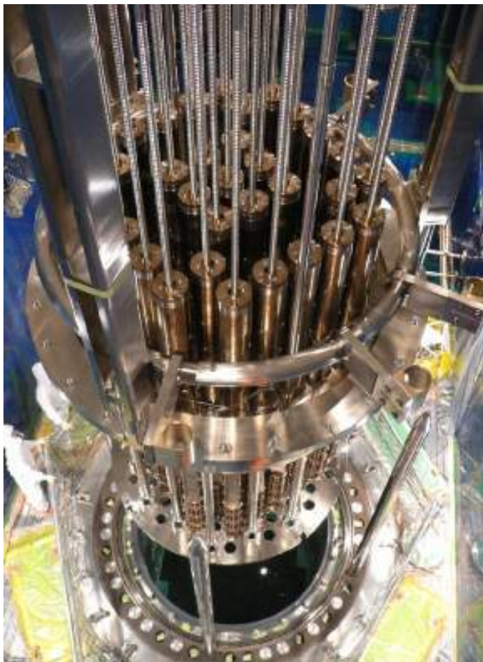
新CI(UCI)の据付状況
