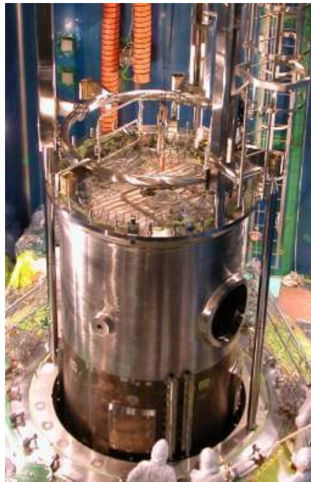
新CI(LCI)の据付状況
