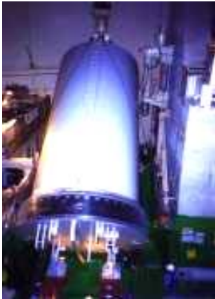
VHR(原子炉容器上蓋取替)状況
