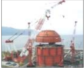
超大容量クレーンによるCV工期短縮
