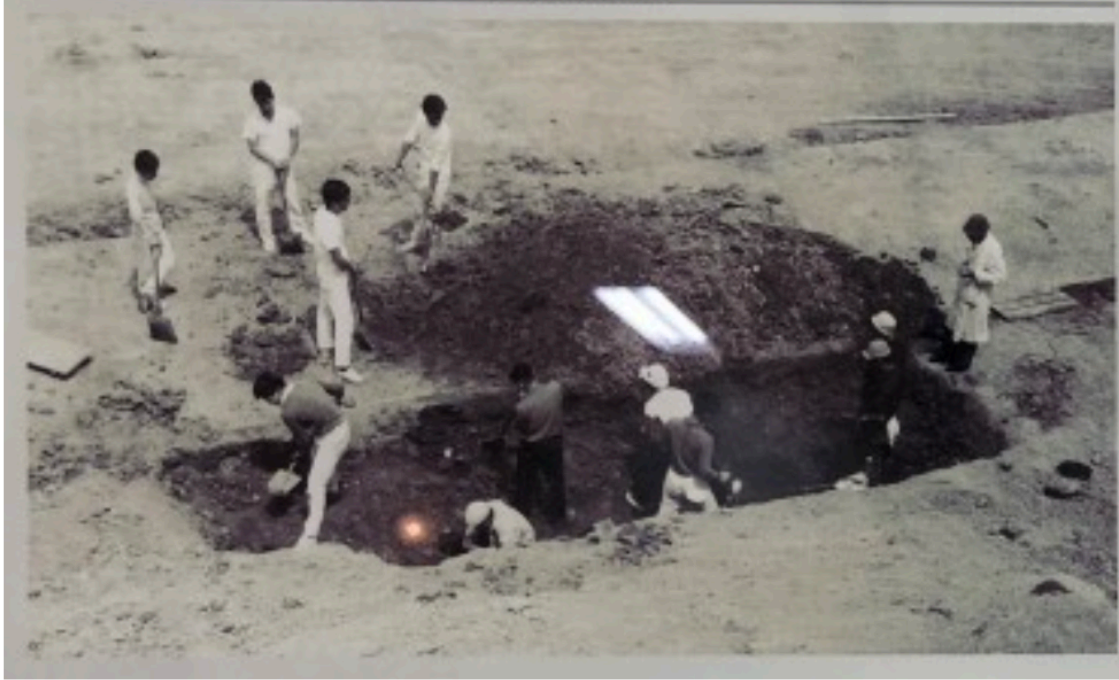
理学部校舎建設現場での発掘風景
